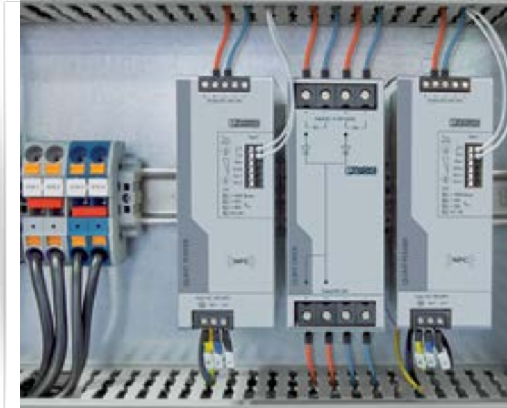
QUINT4-DIODE için örnek uygulama görseli
