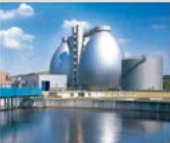
Su / Atık su istasyonu
