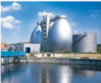
Su / Atık su istasyonu
